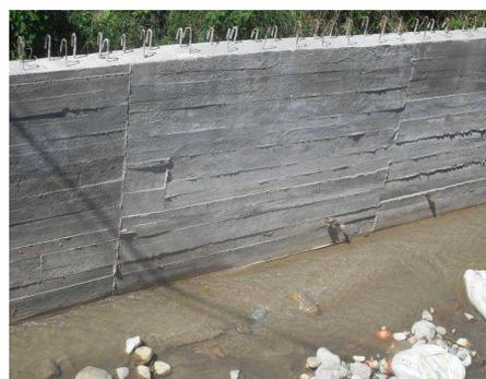
Foto No 19. y 20. Muro contención sobre Quebrada Taruquita - Municipio de Mocoa. Interventoría y supervisión.
